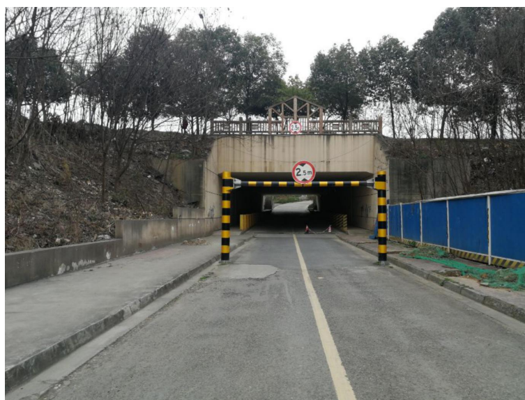
图 22 凤林二路下穿工程现状
