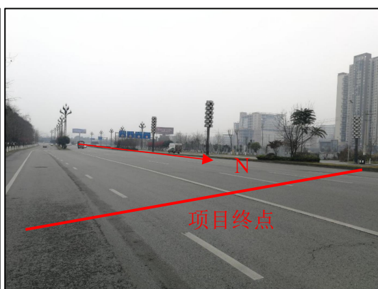
图 5 项目终点现状
