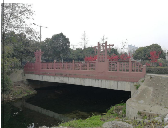
图 20 海滨堰桥梁现状
