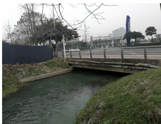
图 21 金马支渠桥梁现状
