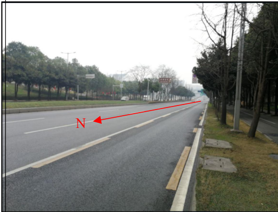
图 2 项目起点现状
