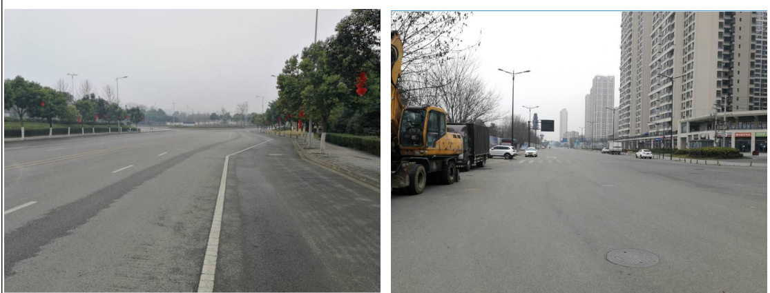
图 15 熊猫大道、甫家二路路面现状图
