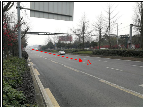
图 3 跨金芙蓉大道落地后路段现状
